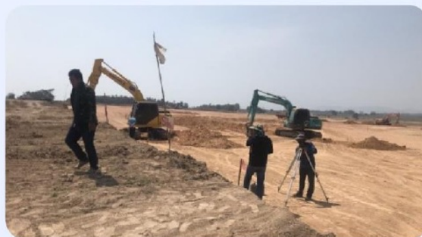
อิสทวอเตอร์ (ผู้ประกอบการประปาและบำบัดน้ำเสีย) อยู่ระหว่างสำรวจสภาพพื้นที่และออกแบบค่าระดับ
